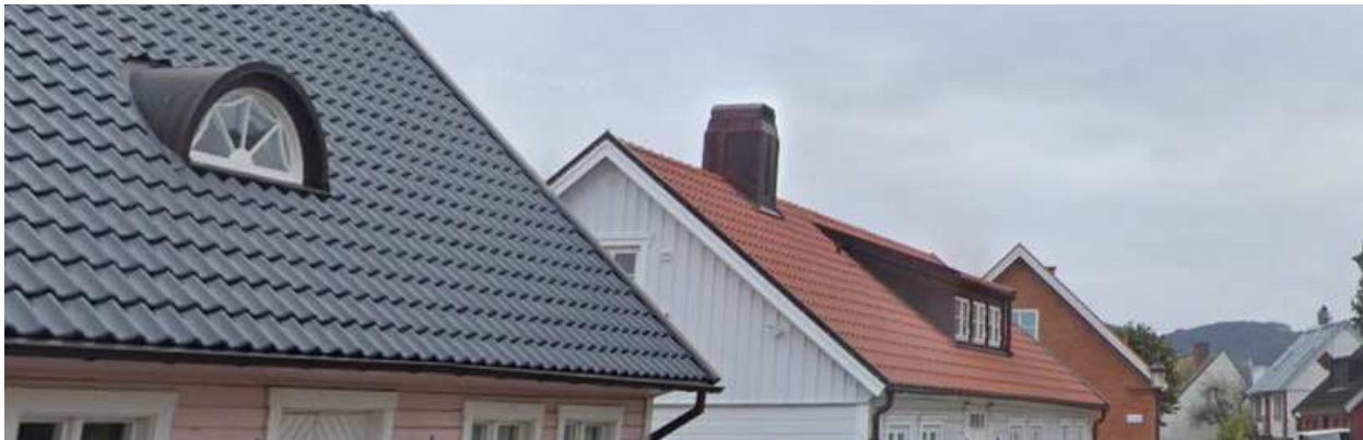
Bild visar tak (närmast i bild) försett med mindre homeja på Agardhsgatan. Källa: Google maps.
