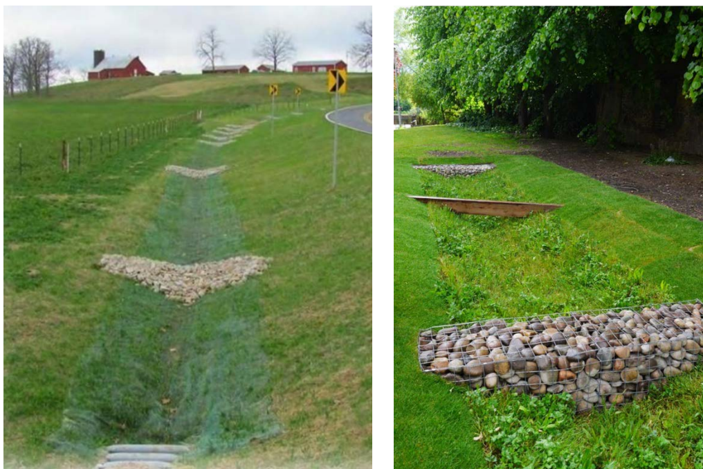
Figur 13. Diken med dämnen (foto: Tyréns respektive Boverket).
