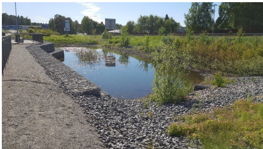
Figur 14. Exempel på dagvattendamm (foto: AFRY).
