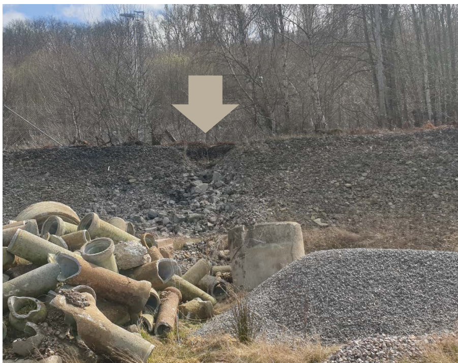
Figur 18. Visar den plats på banvallen där man ser att gruset sköljts bort.
