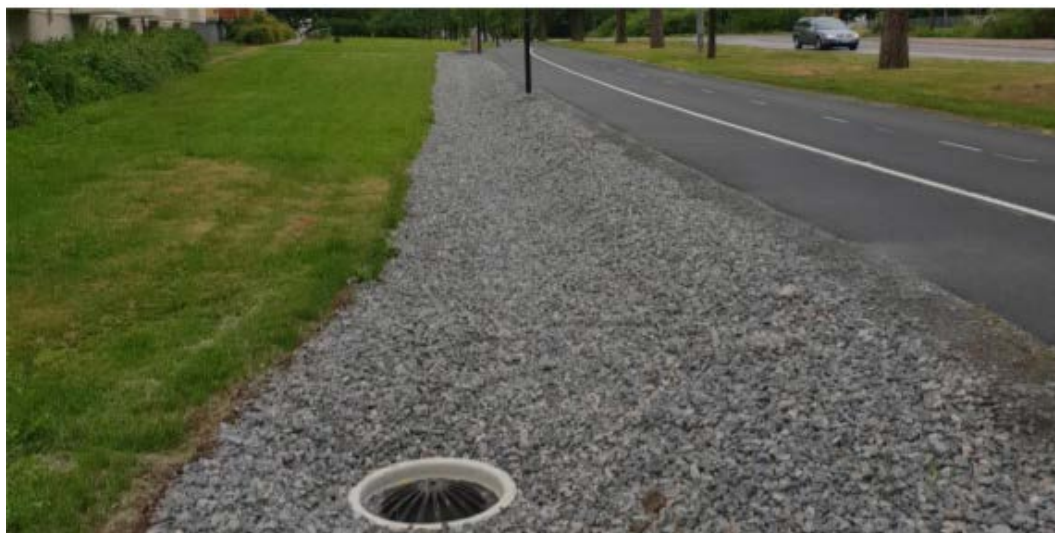
Figur 16. Exempel på makadamdike (foto: Dämningsverket).
